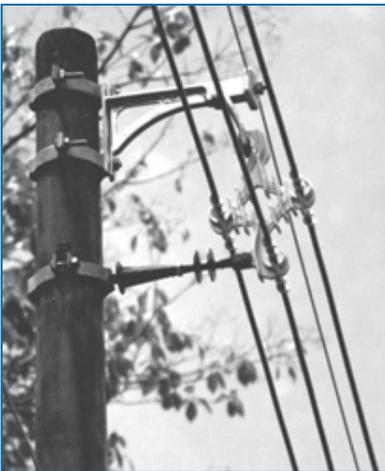
Accesorio de material polimérico cuya función es la fijación del espaciador poligonal, evitando la aproximación ó el distanciamiento de los cables protegidos junto a las estructuras y reduciendo de este modo, la vibración mecánica de las líneas compactas clases 15 y 35 kV.
