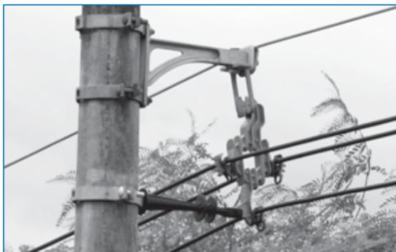
Herraje en forma de "L" que, ubicado en un poste, tiene la función de sustentación del cable mensajero de las líneas compactas de clase 15 kV, en condición tangencial ó en ángulos de deflexión de no más de 6°.
