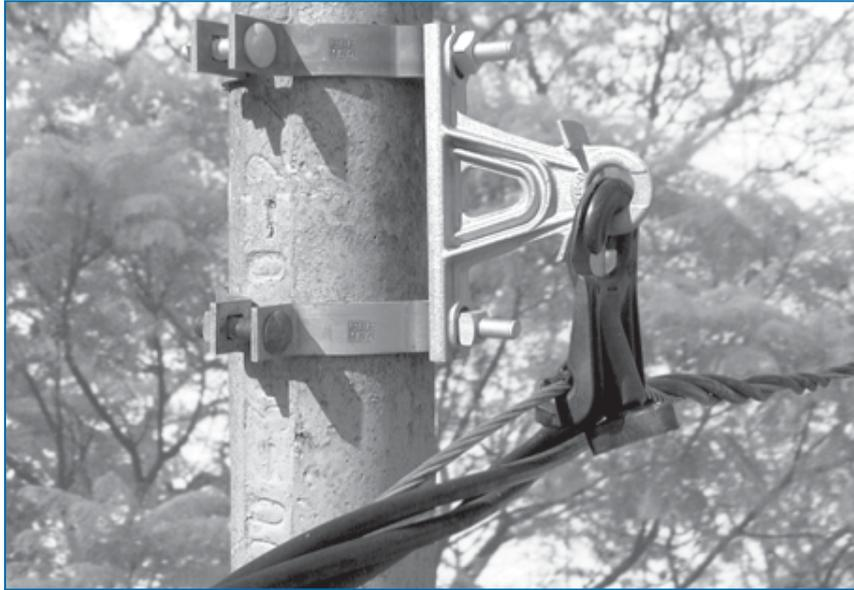
El Conjunto Grapa de Suspensión para Preensamblados – GSE se destina a la suspensión de cables preensamblados en redes secundarias ó primarias hasta 25 KV.
