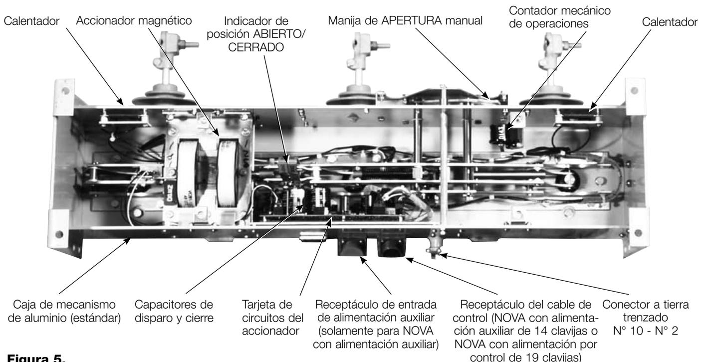
**Figura 5.** Restauradores Kyle NOVA con mecanismos tipo B, C, D y E, ilustrado con interfaz con alimentación auxiliar (vista desde parte inferior del restaurador con cubierta inferior y escudo de seguridad de tarjeta del accionador retirados).
