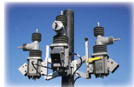
Montaje en bastidor en subestación
