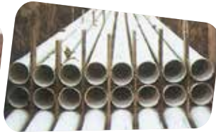
Ducto DB o TDP instalado directamente en el terreno
