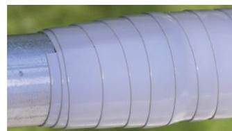
Autofundente, para 15 kV aplicar 1 capa, para 35 kV aplicar 2 capas.
