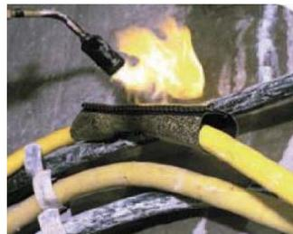
Empalme Tripolar Termocontráctil para Cables Flexibles de 5 y 8 kV, contiene 3 empalmes
