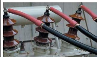
Terminal Termocontráctil para Cable de 15 kV USO EXTERIOR. Cables Pantallas de Hilos y/o Cinta
