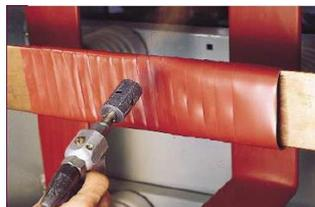
Para 15 kV aplicar 1 capa, para 35 kV aplicar 2 capas.
