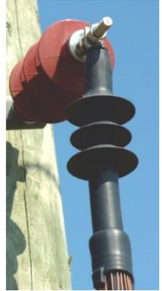
Terminal de media tensión aplicable en frío tipo Pre-Expandido. USO EXTERIOR. 15 kV. Pantalla en Hilos\*
