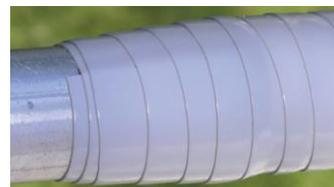
Autofundente, para 15 kV aplicar 1 capa, para 35 kV aplicar 2 capas.
